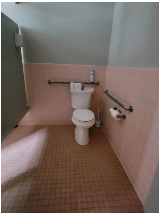
Handicap Accessible Toilet
